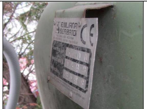
**Figura 4** – Serbatoio n.2 gruppo elettrogeno di emergenza, etichetta -capienza 3 m<sup>3</sup> – Anno 99
