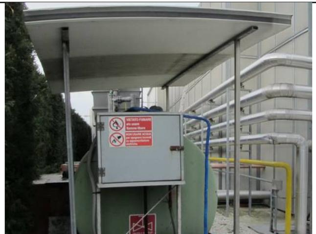
**Figura 6** – Serbatoio n.2 per gruppo elettrogeno di emergenza
