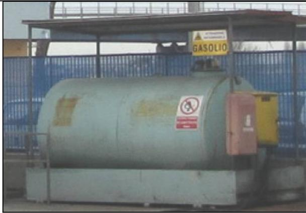
**Figura 1** – Serbatoio 1 di gasolio per rifornimento dei mezzi interni con capienza di 5 m<sup>3</sup>
