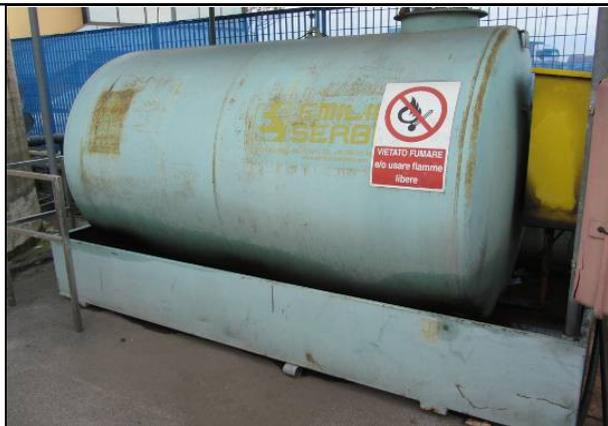
**Figura 3** – Serbatoio 1 – Sistema di contenimento di sversamenti
