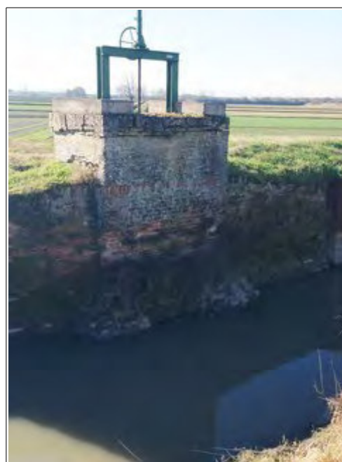
Illustrazione 9: Vista del fronte di presa, con acqua bassa.
