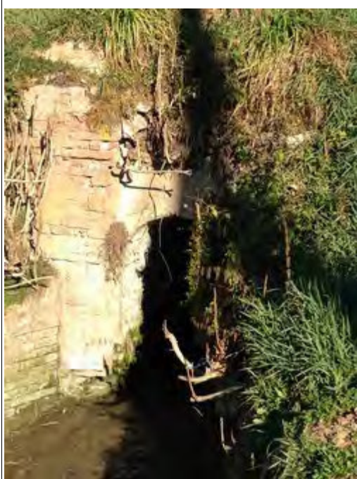
Illustrazione 8: dettaglio del frontino di valle.
