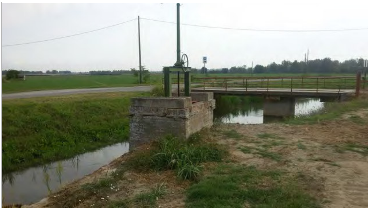
Illustrazione 5: Vista del manufatto di manovra.
