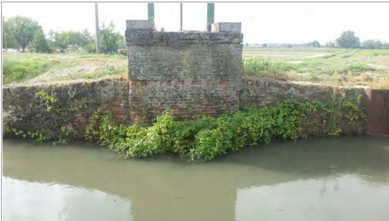
Illustrazione 3: Vista di dettaglio dello stato di conservazione del fronte del manufatto di presa.
