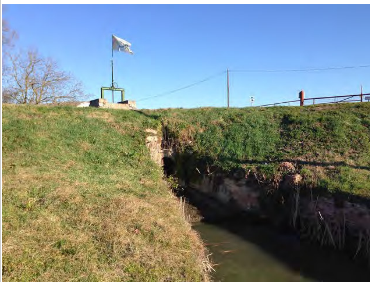
Illustrazione 7: Vista del lato di valle del manufatto di presa.
