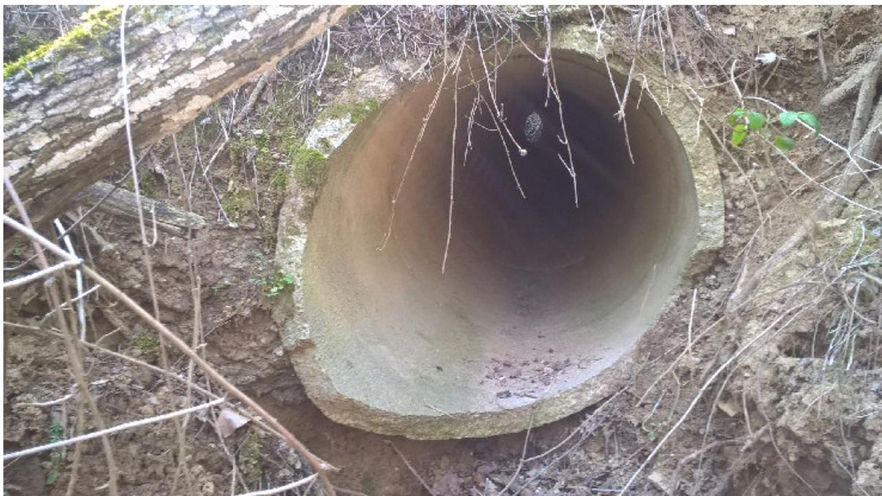
**Figura 3: Particolare del tubo in cls DN800 , tratto uscita a valle.**
