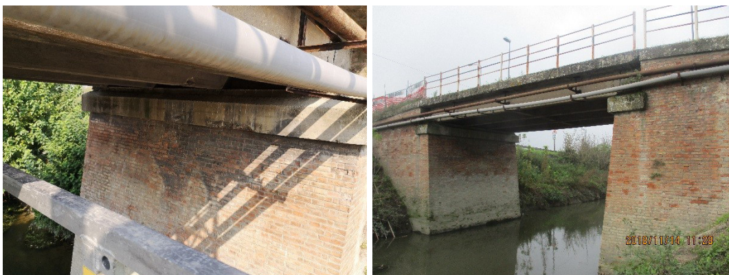
Figura 2.4: Veduta delle Spalle.
