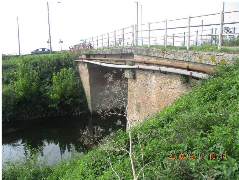
Figura 2.1: Vista laterale manufatto esistente.
