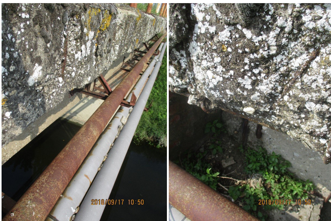
Figura 2.2: Cordolo esistente bordo ponte.
