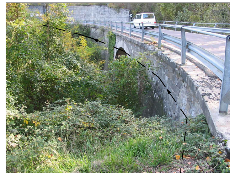
FOTO 7 - ATTRAVERSAMENTO RIO FREDDO - TRATTO STAFFATO PONTE
