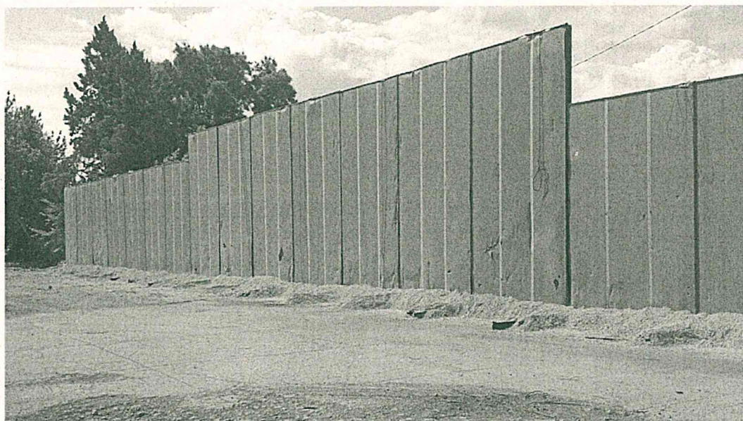
Immagine 2: Vista dei pannelli sul confine sud allo stato attuale.
