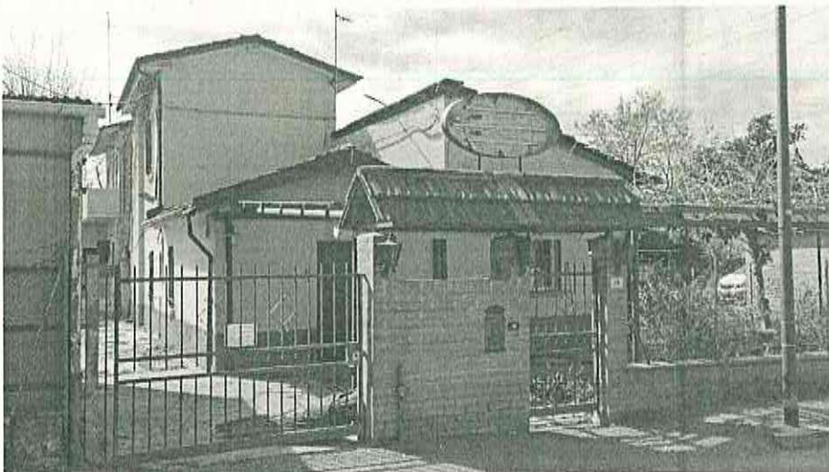
**C.2) Fabbricato in lamiera denominato "Tettoia Chiusa adibita a sala ristorante"-** è realizzato in carpenteria metallica, presenta una pianta regolare rettangolare di mq 103,00 e, seppur non fatiscente, non sembra in uso da tempo e comunque non offre caratteristiche di coibentazione termica atte a soddisfare i requisiti di comfort previsti. Inoltre non risulta disponibile documentazione che attesti la rispondenza alle azioni sismiche della struttura.
