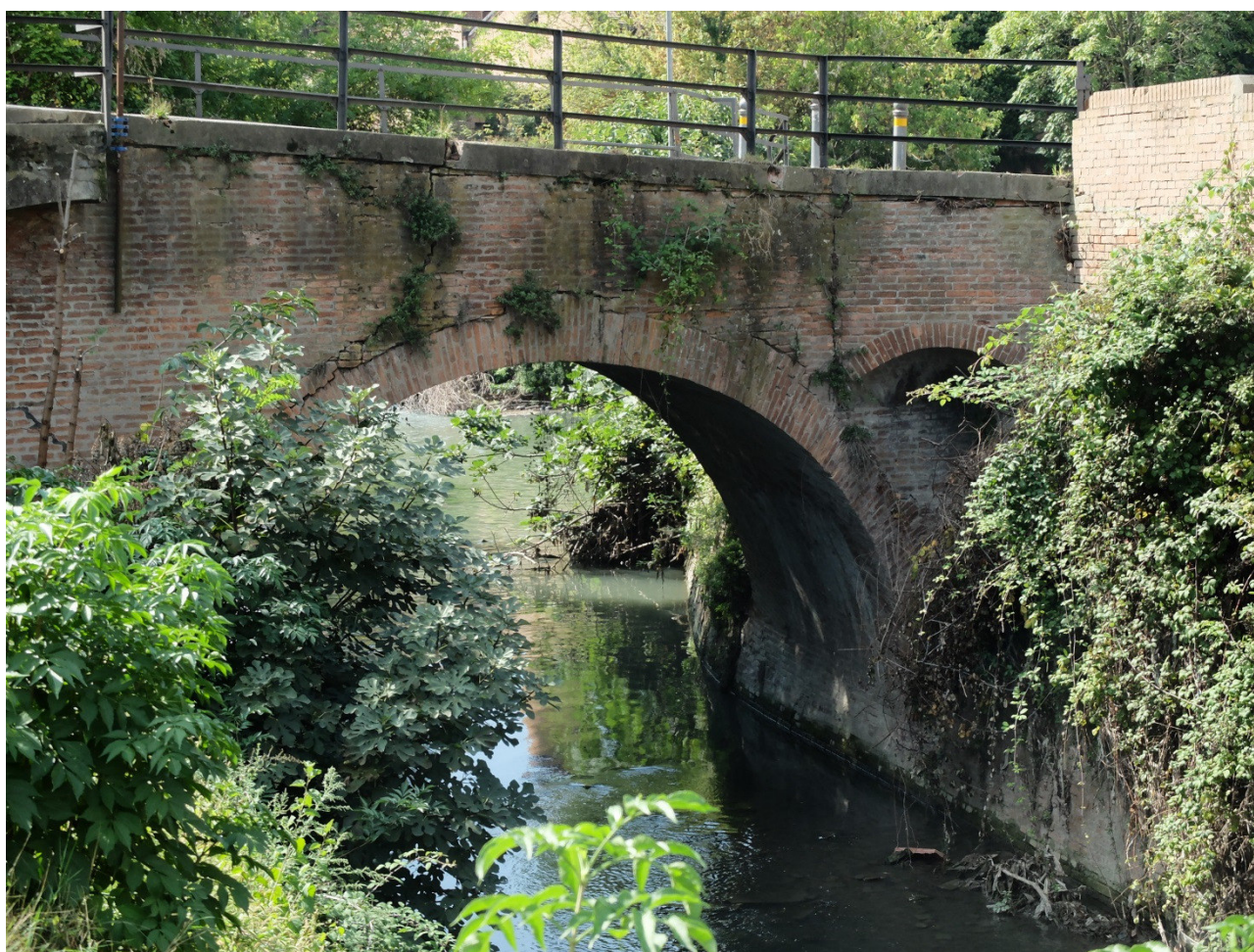
Figura 23 - L'arco in laterizio e la volta ad unghia di raccordo con l'argine occidentale
