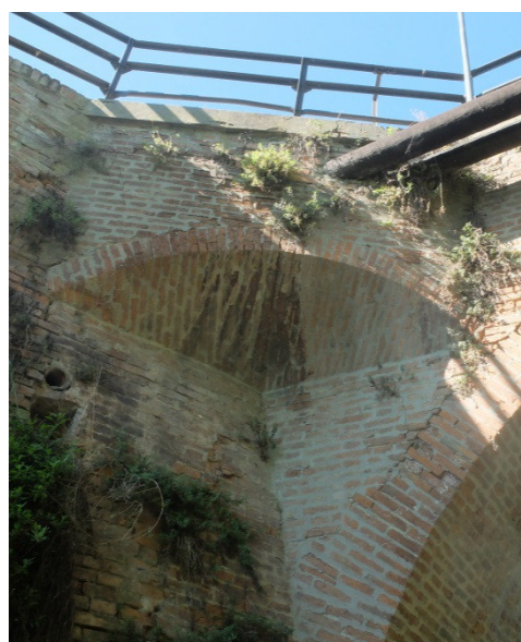
Figura 15 e 16 – La campata in muratura nell'immagine di sinistra, il dettaglio della voltina di raccordo nell'immagine di destra.
