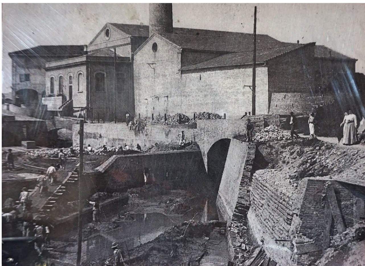
Figura 4 – Bologna, Via della Beverara: il sostegno del Battiferro. La foto del 1905 documenta i lavori che riguardarono modifiche sostanziali, eseguiti nel 1905, necessari dopo l'entrata in funzione nel luglio 1900 della Centrale Idroelettrica, di cui si vede il lato est in alto a destra. Le modifiche consistettero nell'abbassamento del fondo del canale e nella costruzione di una diga (al centro della foto) per aumentare il salto delle acque necessario per alimentare la potente turbina della centrale. Venne anche scavato un collettore ad arco per portare l'acqua del canale alla turbina e innalzati i muri di sostegno del terrapieno nel bacino di espansione.
