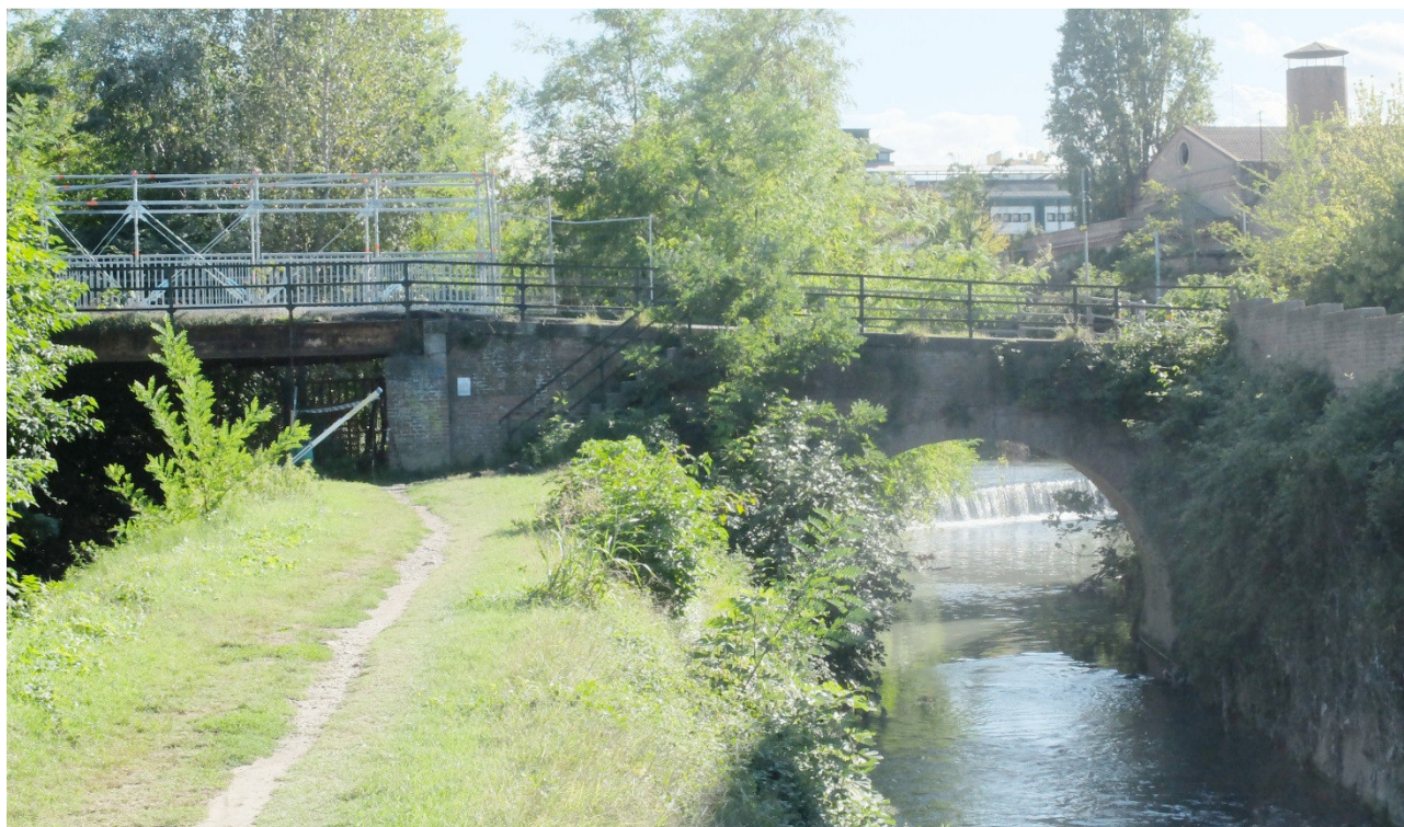
Figura 21 - Il fronte nord del ponte
