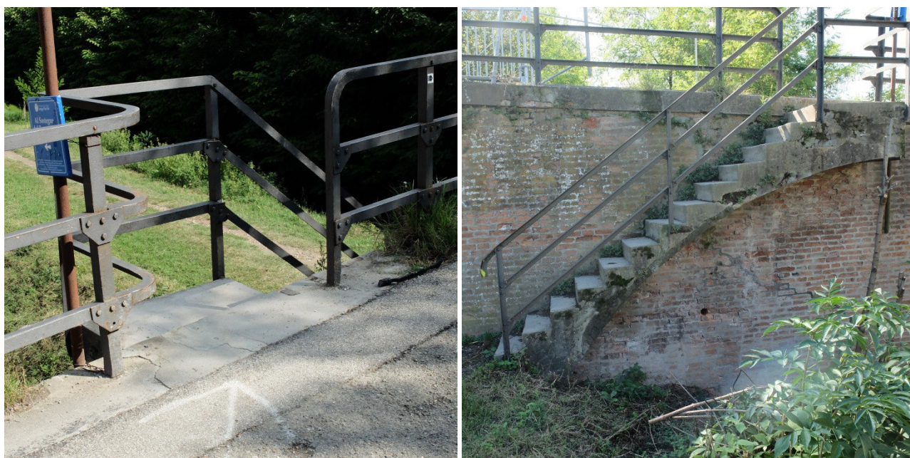
Figura 32 e 33 - Sulla sinistra, il varco nel parapetto sul pianerottolo di arrivo della scala, la scala ad arco in laterizio intonacato nella foto di destra
