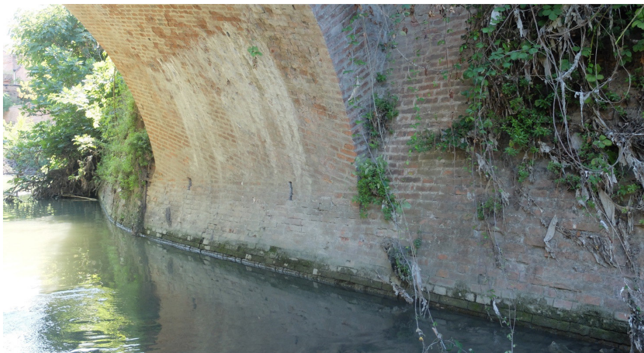
Figura 22 - L'imposta dell'arco sulla sponda occidentale
