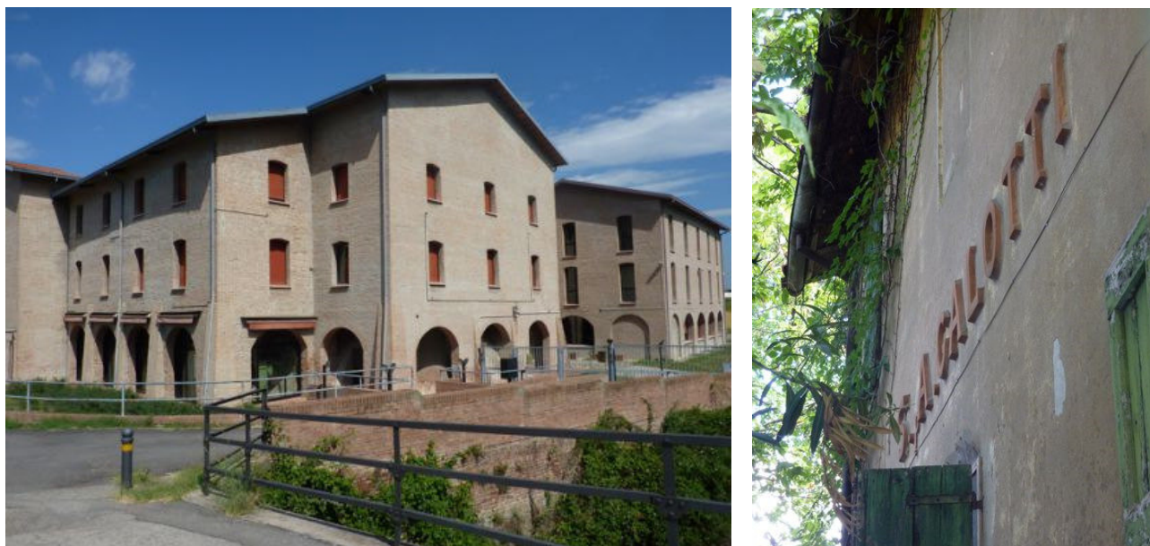
Figura 7 e 8 – Sulla sinistra, la fornace Galotti oggi, che ospita il Museo del Patrimonio Industriale di Bologna; nell'immagine di destra, l'iscrizione della società anonima Galotti sull'edificio posto all'ingresso del complesso, oggi su via della Beverara.
