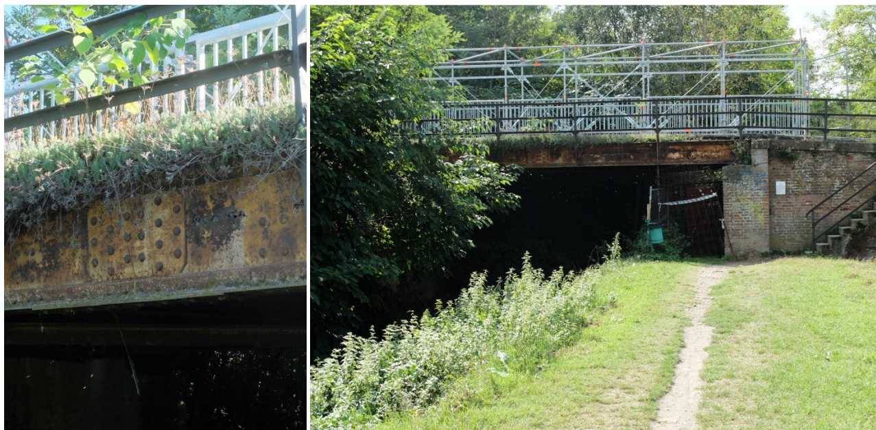
Figura 17 e 18 – Il dettaglio della chiodatura nell'immagine di sinistra, la campata con struttura metallica nell'immagine di destra.
