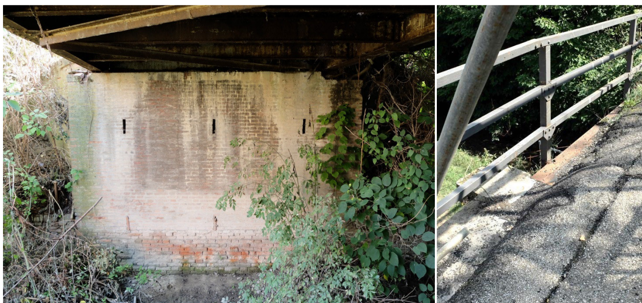
Figura 28 e 29 - La spalla orientale del ponte, con la sella in sommità per l'appoggio della struttura metallica e le riseghe laterali di raccordo con l'argine ribassato nell'immagine di sinistra, a destra il punto di giunzione tra il cordolo dei paramenti murari e la trave di bordo sul piano stradale, fronte nord
