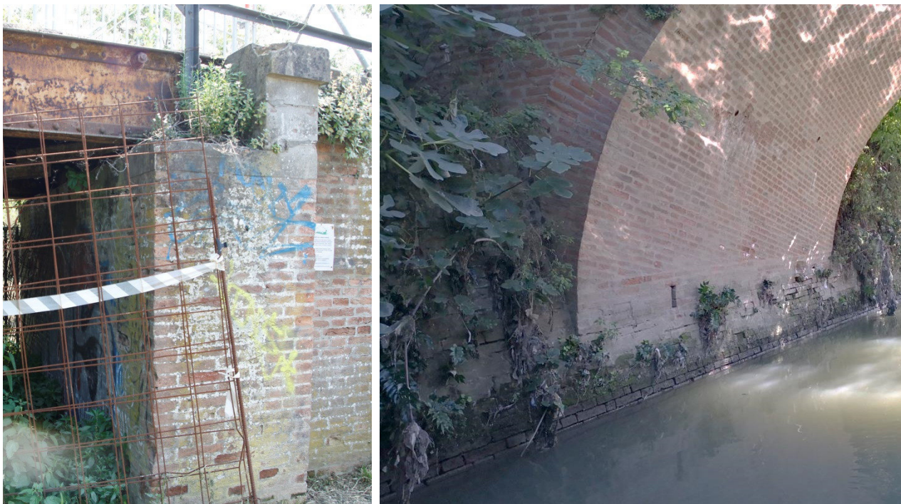
Figura 24 e 25 - La spalla in muratura centrale con la sella per l'appoggio delle travi di bordo nell'immagine di sinistra e a destra l'imposta dell'arco sulla sponda del rilievo tra i due corsi d'acqua
