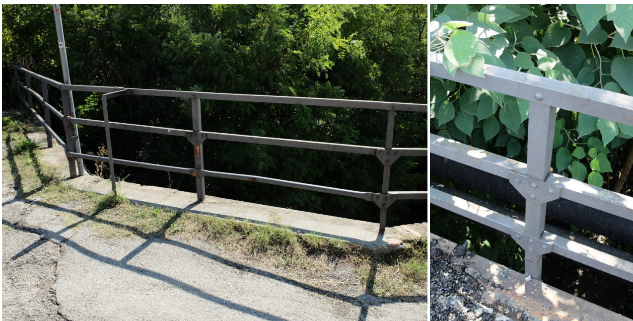
Figura 30 e 31 - A sinistra, un tratto di parapetto sul fronte sud, dove alcuni traversi ammalorati sono stati sostituiti con tubolari, nell'immagine di destra un dettaglio dei piatti di collegamento sagomati all'intersezione tra montante e traversi
