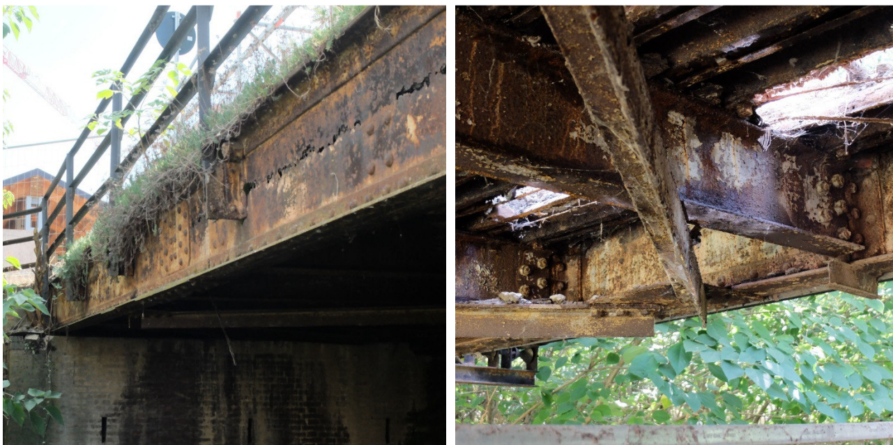
Figura 26 e 27 - La trave di bordo nella foto a sinistra, a destra l'orditura secondaria e i controventi angolari
