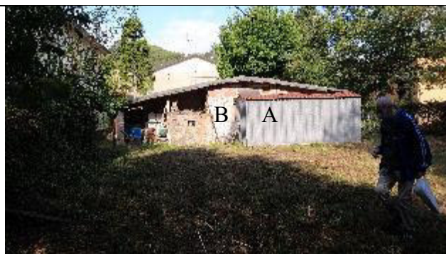
foto 3) il manufatto in lamiera (A) a ridosso del corpo di fabbrica (B) in sconfinamento su area demaniale.
