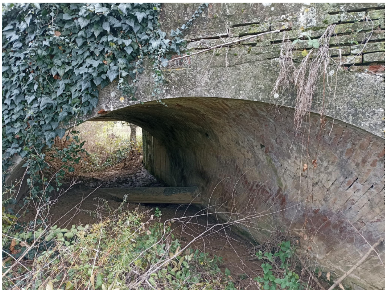
Figura 3 – Tubazione esistente in cemento amianto nel tratto di attraversamento del Rio Sabbioso
