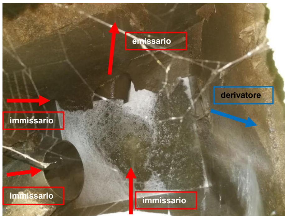
FOTO POZZETTO INTERNO
