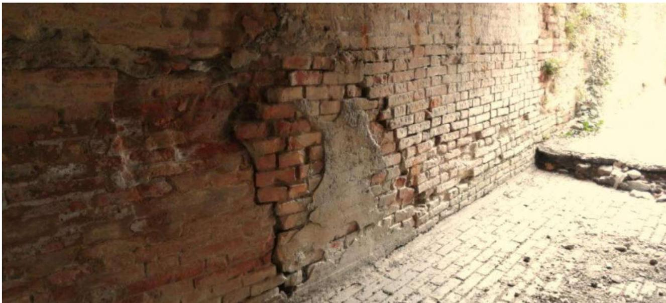
*Vista e dettaglio ammaloramenti spalla est*
