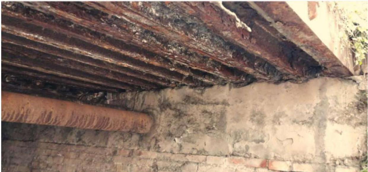
*Dettaglio ammaloramenti travi e lamiera grecata*
