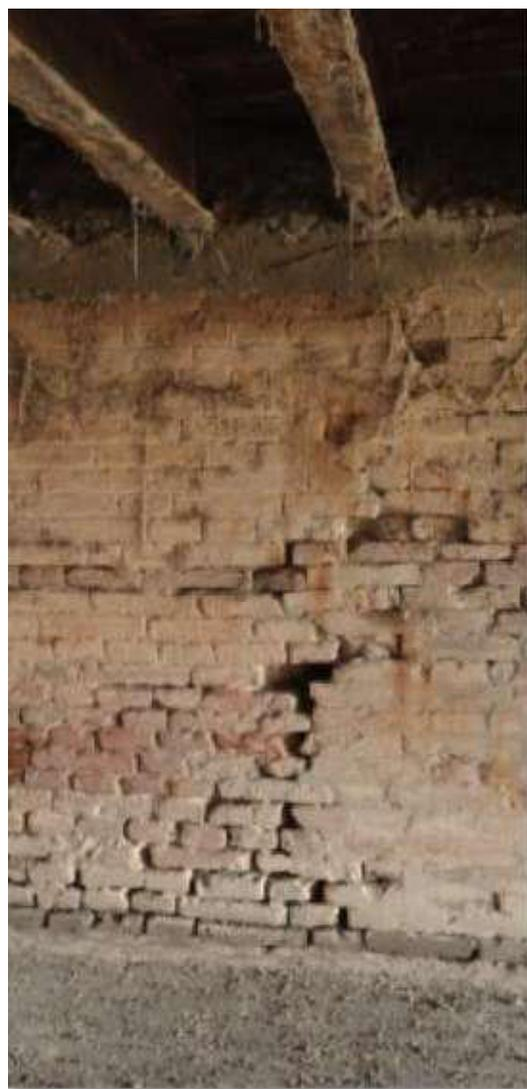
*Vista e dettaglio ammaloramenti spalla ovest*
