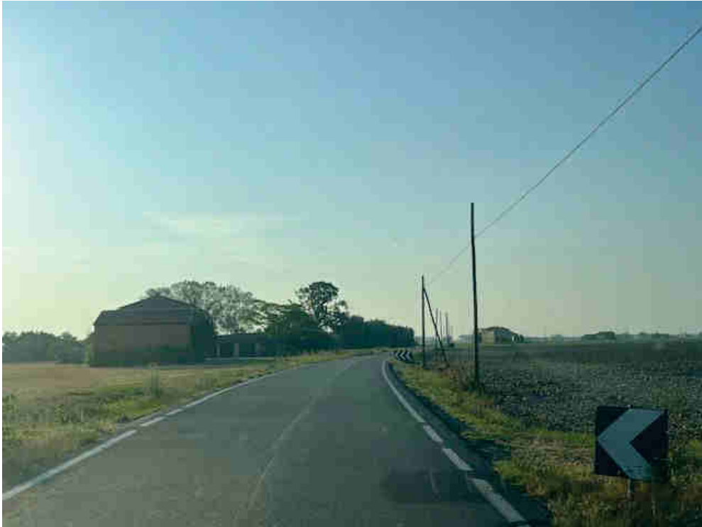
Strada dei Prati, restringimento carreggiata
