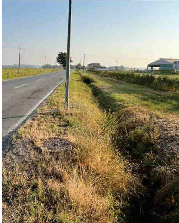
"palificata energia elettrica" e "ispezione fognaria" posta sul lato est di via Ilaria Alpi
