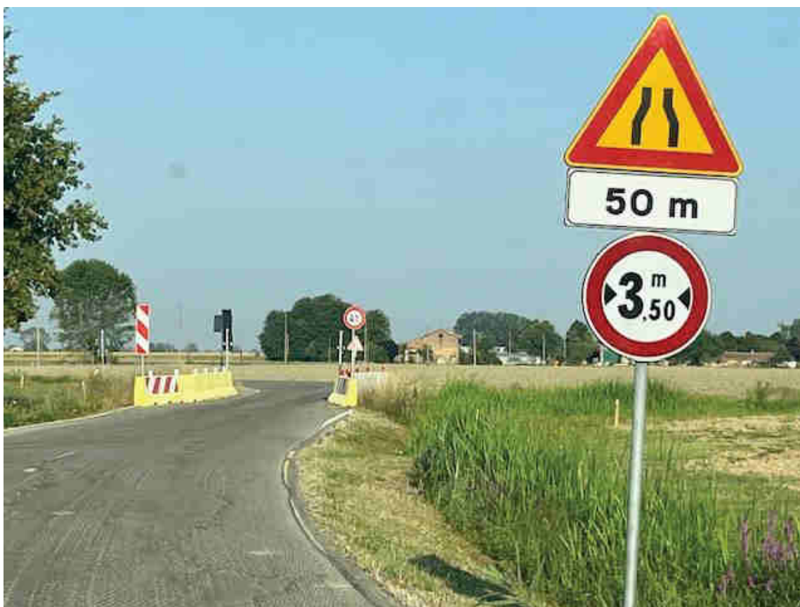
SP 33 "Argine Filippina" – strettoia - restringimento carreggiata (direzione Sissa)
