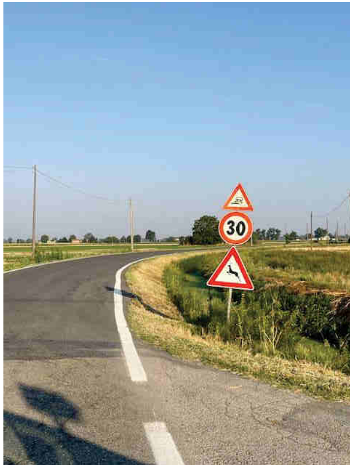
Strada dei Prati, assenza di banchina stradale
