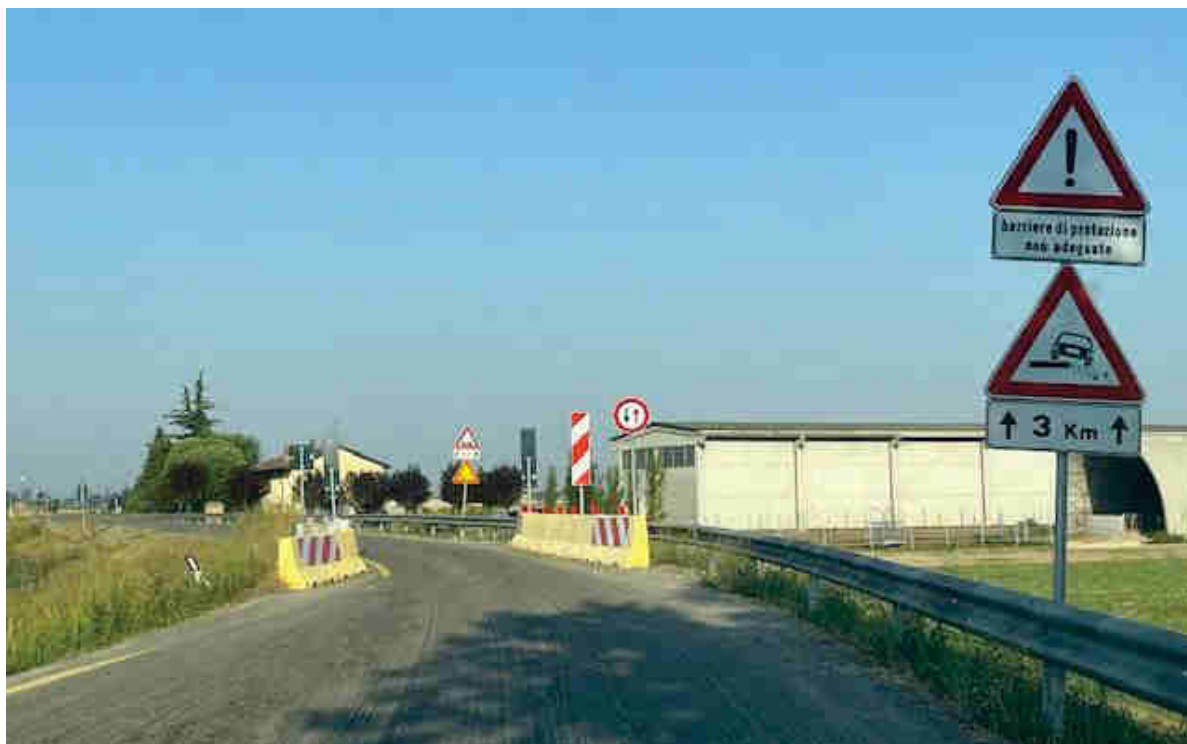
SP 33 "Argine Filippina" – cartelli di pericolo, strettoia a senso unico alternato, banchina cedevole
