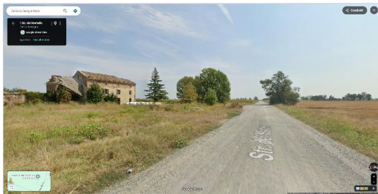
Figure 4: fronte Strada oggetto d'intervento
