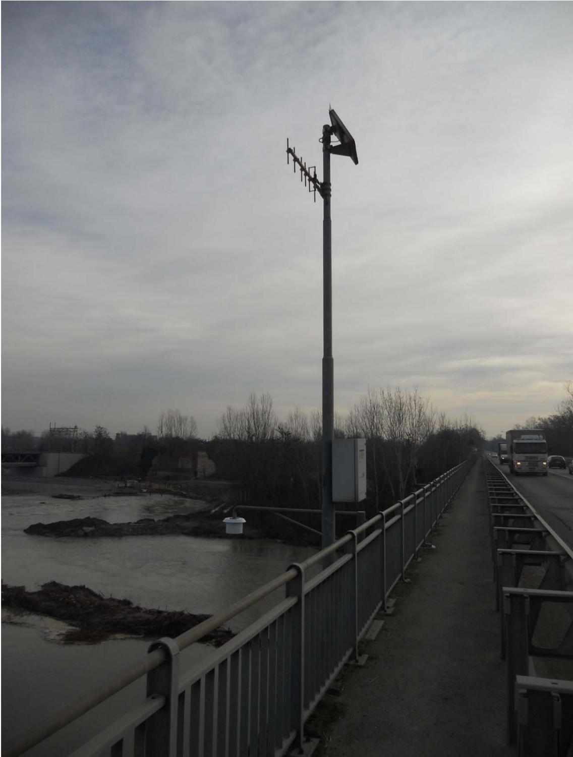
Figura 1 - Stazione idrometrica di Rubiera SS9 (idrometro)
