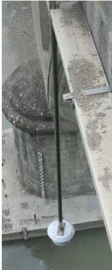
Figura 5 - Asta di supporto per idrometro a ultrasuoni
