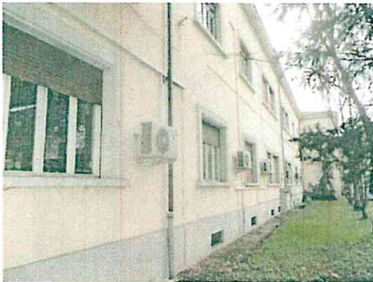
Fig. 2.1.3 – Vista esterna dell'edificio
