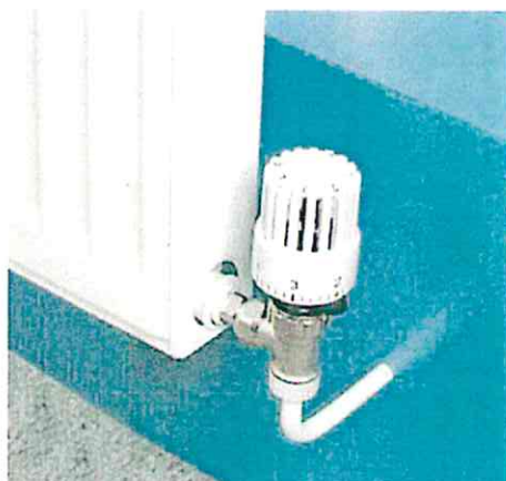
Fig. 3.3.2.1 – Particolare valvola termostatica
