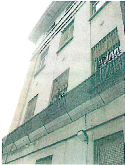
Fig. 2.1.1 – Particolare facciata nord edificio storico
