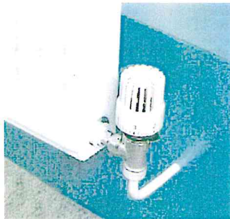
Fig. 3.3.2.1 – Particolare valvola termostatica
