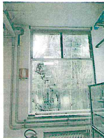
Fig. 2.1.6 – Infissi alluminio e vetro singolo
