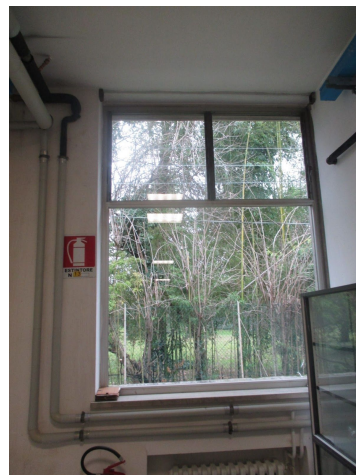
Fig. 1.2.6 – Infissi alluminio e vetro singolo
