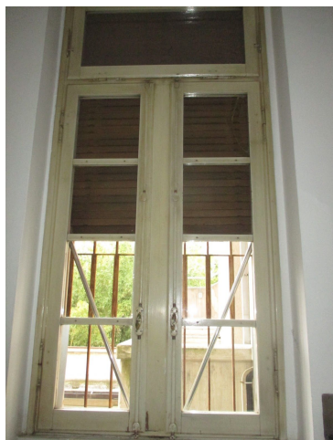
Fig. 1.2.5 – Infissi legno e vetro singolo
