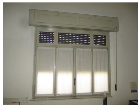
Fig. 1.2.6 – Infissi legno e vetro singolo
