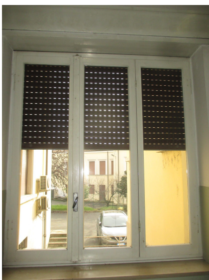
Fig. 1.2.5 – Infissi legno e vetro singolo
