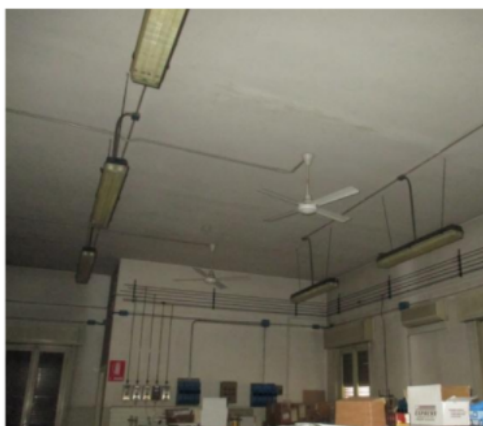
Fig. 1.3.2 – Disposizione illuminotecnica tipo nei locali
