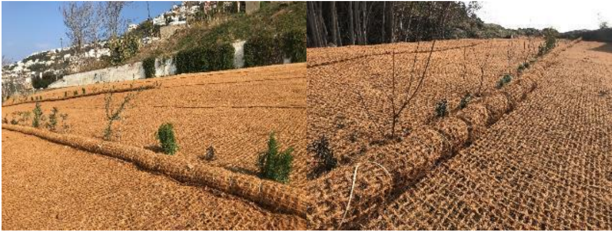
Figura 4-4 esempio di installazione delle reti in fibra di cocco e sistema anti ruscellamento
