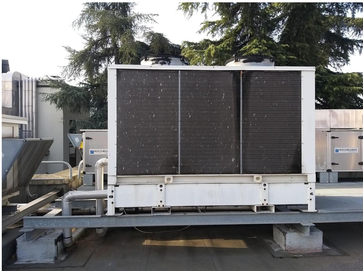
Figura 2 – Gruppo frigorifero esistente da sostituire
