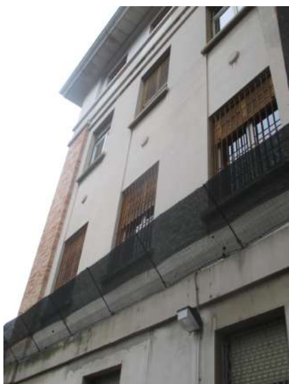
Fig. 1.2.1 – Particolare facciata nord edificio storico
