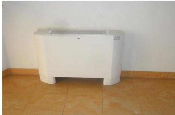
Fig. 1.3.2 – Ventilconvettori
