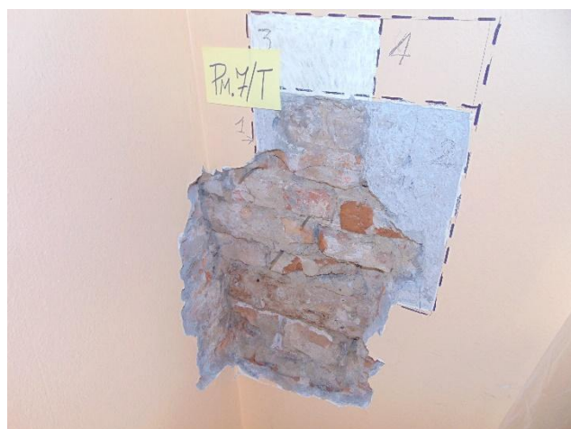
Saggio su elemento murario lvm
