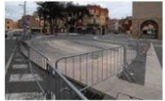
RIMOZIONE AREA DI CANTIERE
