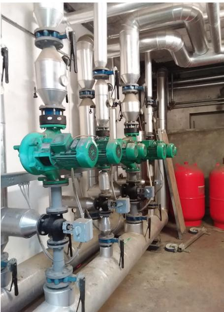
Fig. 2.10 – Collettore secondario sottocentrale
