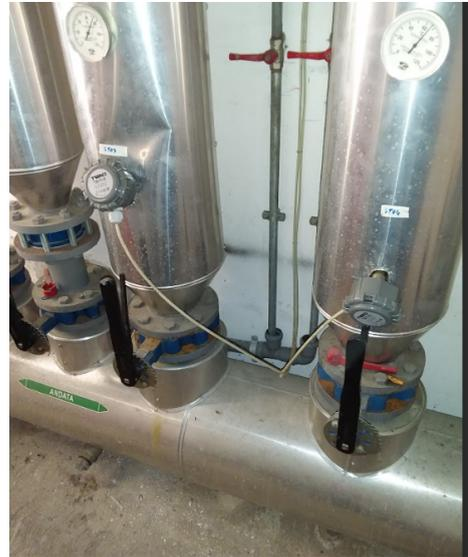
Fig. 2.9 – Collettore primario
