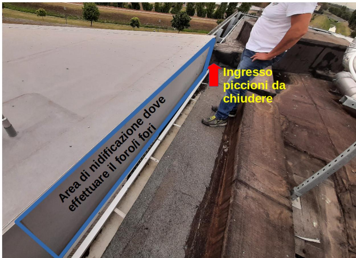
Figura 5. Definizione zona di intervento per la rimozione dei volatili, delle carcasse e del materiale organico
