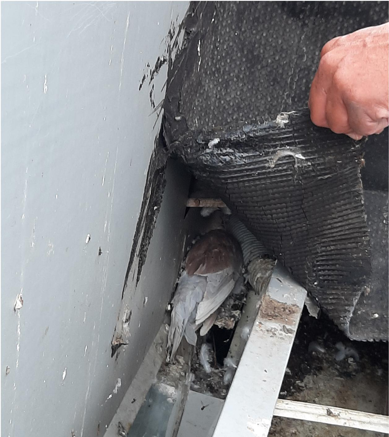
Figura 3. Apertura che permette l'ingresso dei piccioni al di sotto della copertura impermeabilizzante; nella foto è visibile una carcassa di piccione
