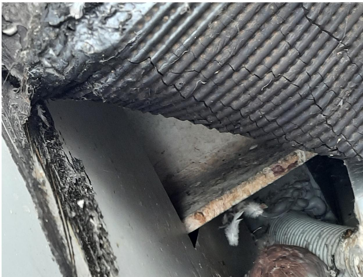
Figura 4. Dettaglio del foro di apertura che permette l'ingresso dei piccioni
