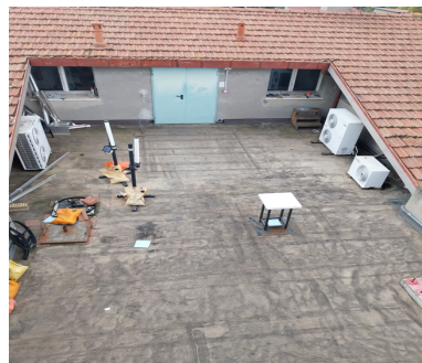
Figura 6.2- Particolare copertura piana
