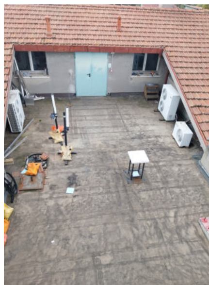
Figura 5- Particolare copertura piana
