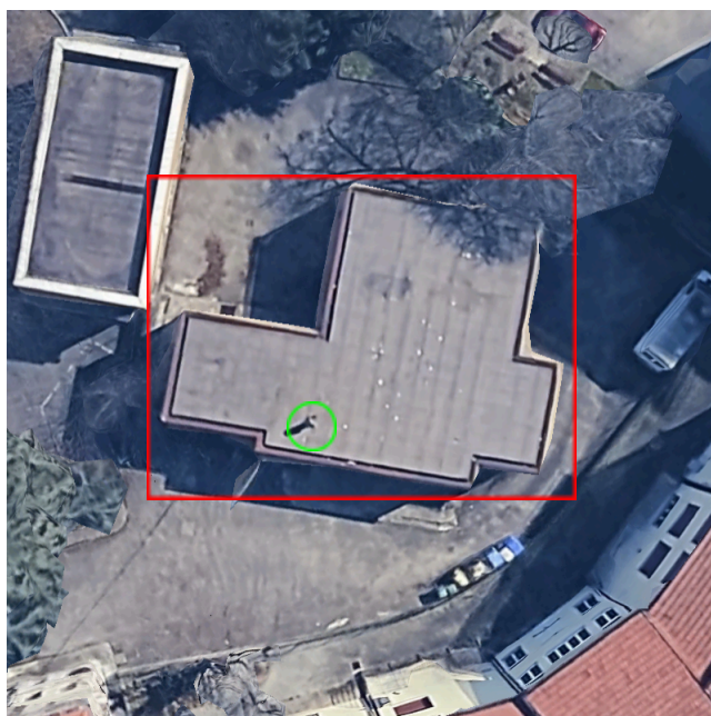
Figura 1. Veduta aerea dell'edificio accessorio.
